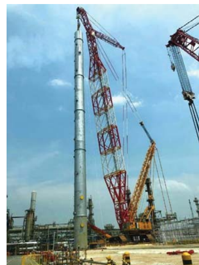
シンガポールの現場でタワーを吊り上げる世界最大級のLBCであるCC 8800-1
